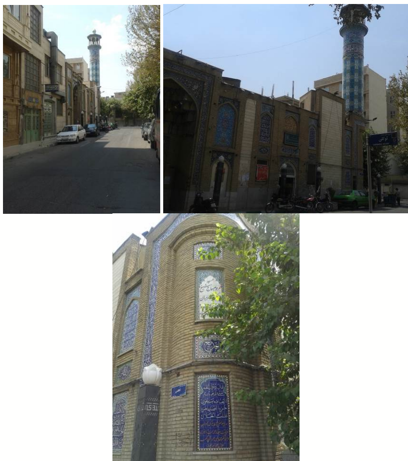
شکل ۱۰- منظر و فرم و تزیینات بیرونی مسجد لرزاده
